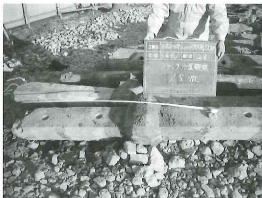
写真-1 三角節杭の目視検査
